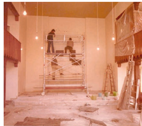
Befestigung der Elemente an der Wand
